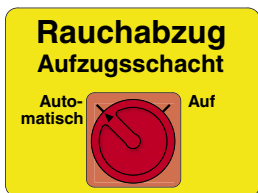
Abbildung 2: Der Schalter zur Bedienung der Lüftungsklappen im Aufzugsschacht respektive im Maschinenraum. Wichtig ist eine sehr gut sichtbare Beschriftung. Anstelle eines Drehschalters lässt sich auch ein Feuerwehr-Schlüsselschalter installieren.
